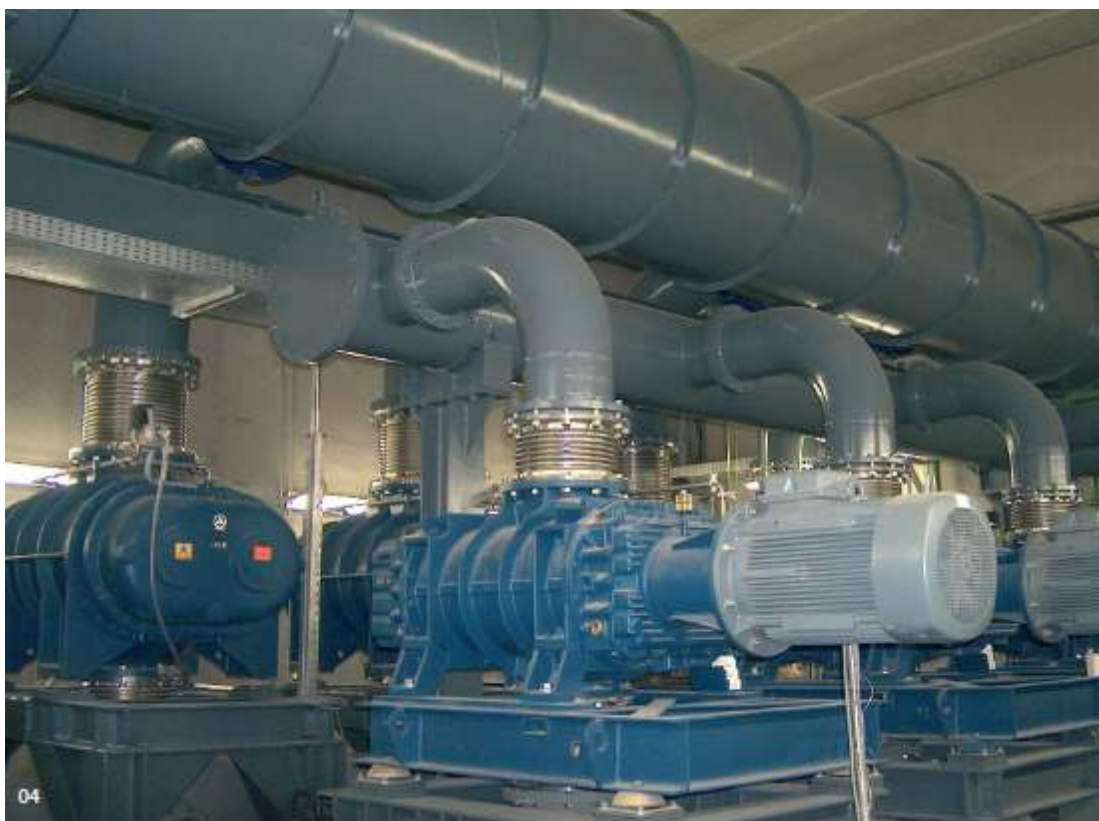
04 Усилители вакуума, соединенные параллельно. С разрешения Aerzen Machines Ltd.
